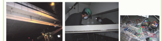
対象橋梁 橋梁へのセンサーの設置
